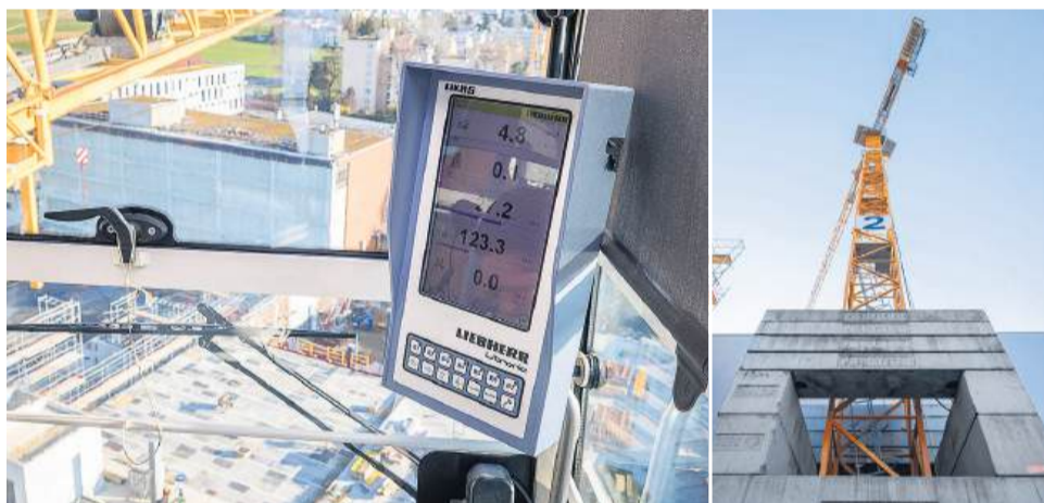
ARBEITSPLATZ IN LUFTIGER HÖHE: Von hier aus erleichtert Daniela Wittwer das Leben der Baubúezer unter ihr. Aber was, wenn sie mal auf die Toilette muss?
