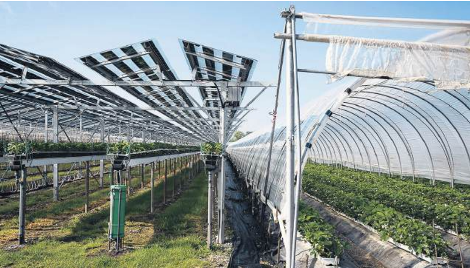
AGRI-PHOTOVOLTAIK: So sieht es aus, wenn eine Fläche gleichzeitig für die Landwirtschaft und die Energieerzeugung genutzt wird. FOTO: KEYSTONE
