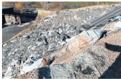
GEFÄHRLICH: Asbesthaltiges Material wurde im Wallis achtlos ausgeschüttet. FOTO: ZVG
