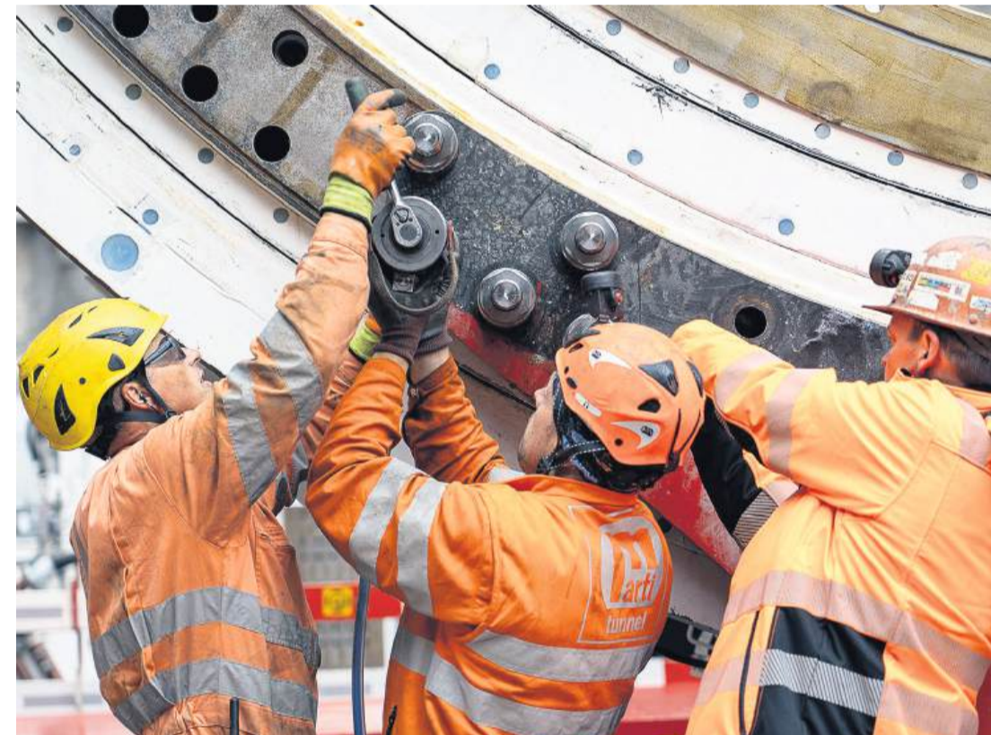
TEAMWORK: Mit vereinten Kräften verschrauben die Búeizer die Tunnelbohrmaschine.
