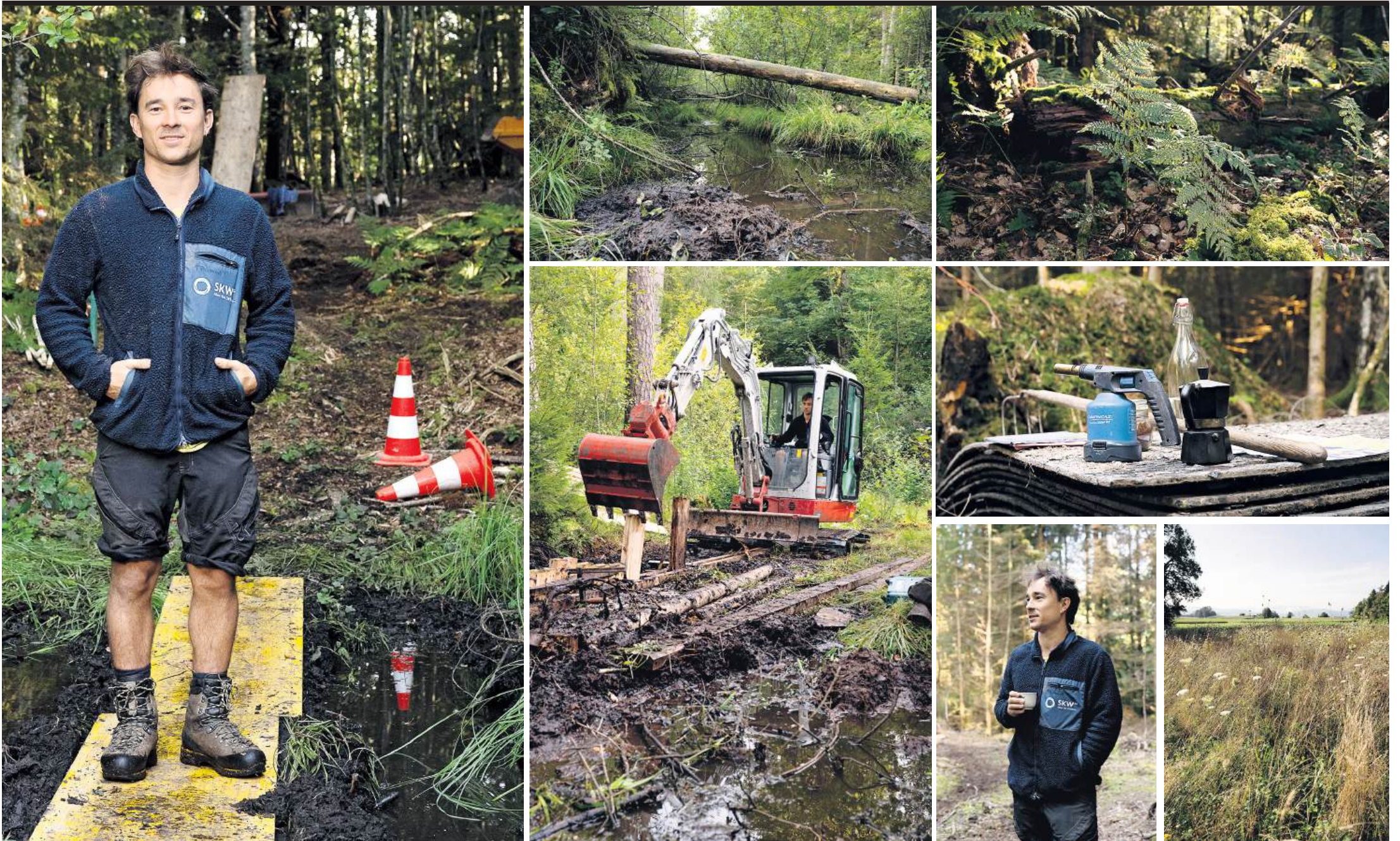
DER RENATURIERER: Im Mooregebiet des Zürcher Säuliamtes versenkt Gian Baumberger mit seinem Bagger Holzpfähle im Waldboden – für mehr Biodiversität. FOTOS: RAJA LÄUBLI
