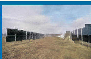
Dauergrünland: Vertikale Module in Ost-West-Aufständung. Nennleistung: 293 kWp/ha. Spezifische Jahresleistung: 1000 kWh/kWp, Flächenertrag von 293 MWh/ha/a.
