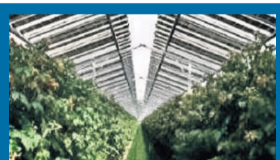
Dauerkulturen: Anlagen mit semitransparenten Modulen. Nennleistung: 737 kWp/ha. Spezifische Jahresleistung: 1170 kWh/kWp, Flächenertrag von 862 MWh/ha/a.
