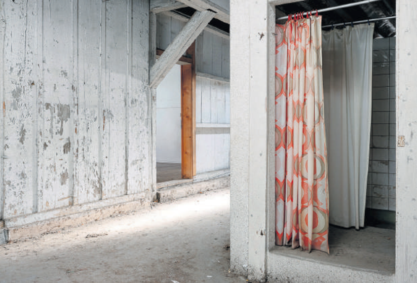
MITTEN IM DURCHZUG: Das ist eine von zwei Duschen in dieser Baracke.
