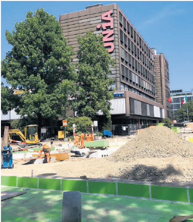
ALLES AUFGERISSEN: 80 Büezer bauen vor der Unia-Zentrale an einem neuen Verkehrsknotenpunkt.
