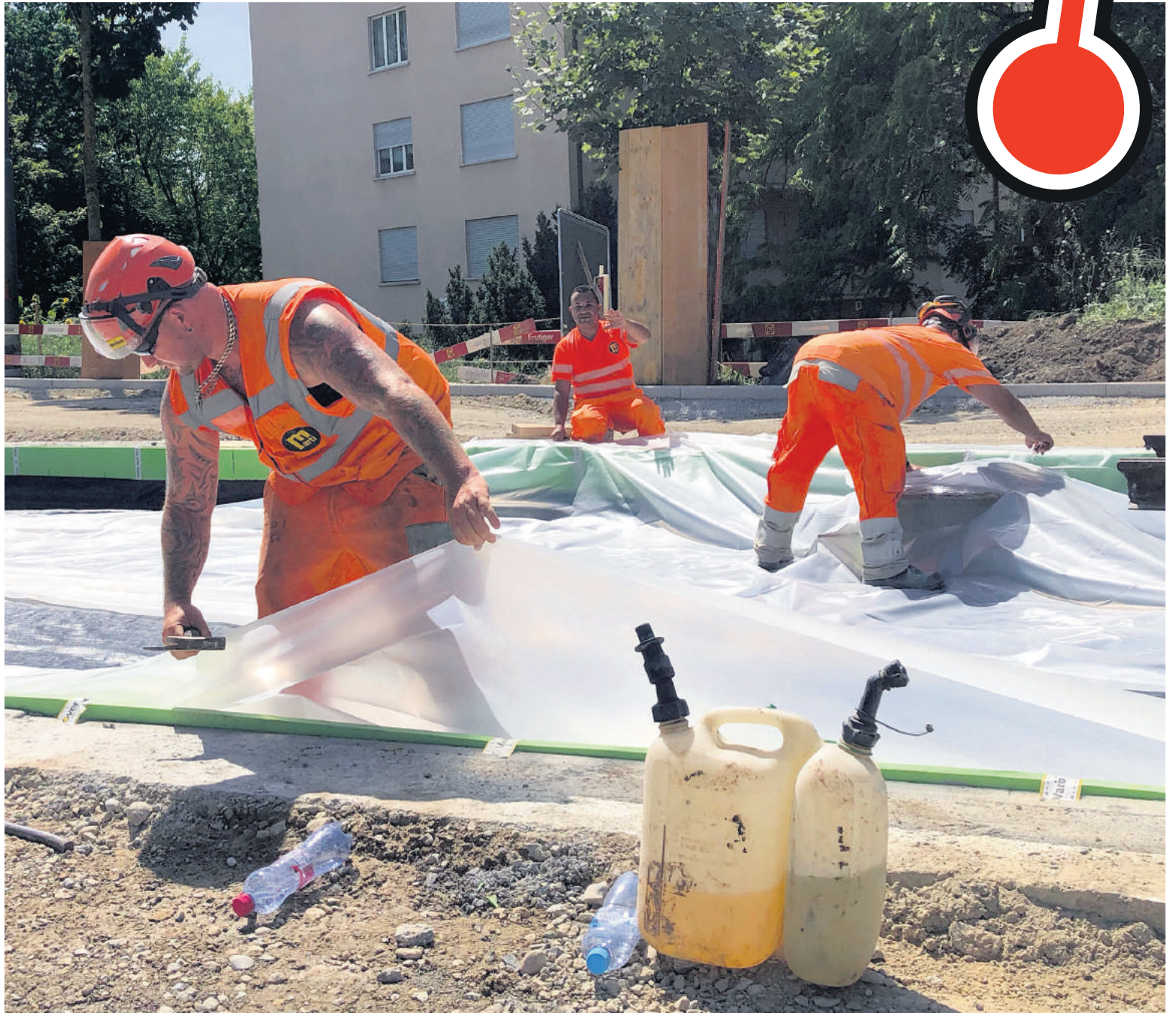
HÖLLISCH HEISS: Bevor die Bauarbeiter mit dem Betonieren anfangen können, müssen sie isolieren. Einer der Büezer erzählt: «Auf den Isolationsfolien haben wir gestern 44 Grad gemessen.»
