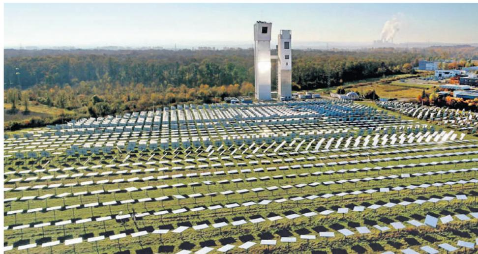
SONNE ZU TREIBSTOFF. Zig Spiegel-Panels reflektieren in der Testablage in Jülich (D) Sonnenlicht an einen Solarempfänger am Turm. Dieser erzeugt die nötige Hitze zur Kerosin-Produktion. FOTO: SYNHELION
