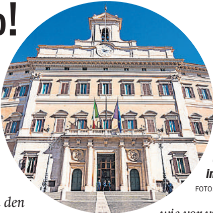
NIEDERLAGE: Das fortschrittliche Lager machte zu viele Fehler. Jetzt regiert die Rechte im Parlament.
