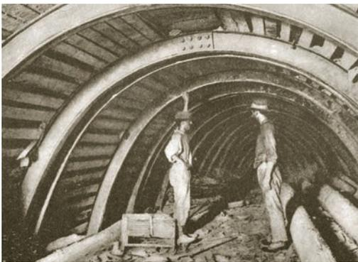
Tunnel 1: Gewölberahmen mit Eisenbügeln.
