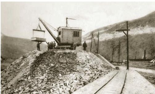
Elektrokran beim Abladen des Abraums aus dem Tunnel.
