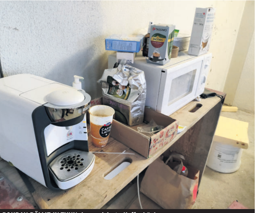
ROHBAU BÄLLIZ IN THUN: Improvisierte Kaffeeküche.
