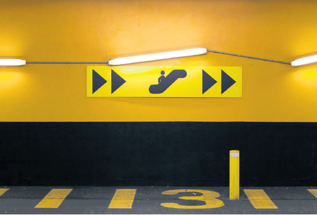
LICHT INS DUNKEL: LED-Röhren verbrauchen viermal weniger Strom als Neonröhren. FOTO: KEYSTONE
