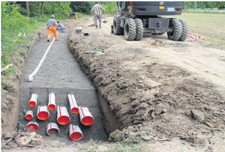
**UNTERIRDISCHE SPANNUNG:** Erdverlegte Hochspannungsleitungen transportieren Strom ohne die traditionelle Verwendung von Hochspannungsmasten. FOTO: AET
