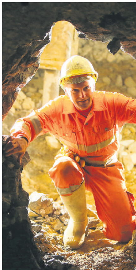
DURCHBRUCH: Ein Mineur beim Neubau des Albulatunnels der Rhätischen Bahn von Preda nach Spinas GR. FOTO: KEYSTONE
