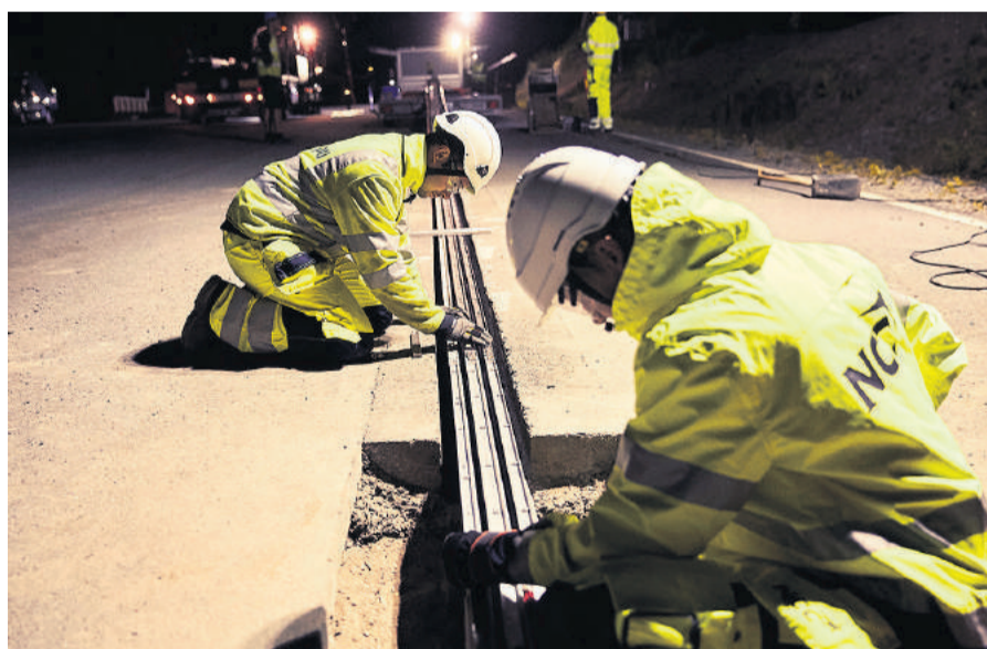
IN DER SCHIENE LIEGT DIE KRAFT: Montage von stromführenden Schienen unter dem Deckbelag der Strasse. Sie versorgen die Motoren der E-Autos mit Energie. FOTO: EROADARLANDA
