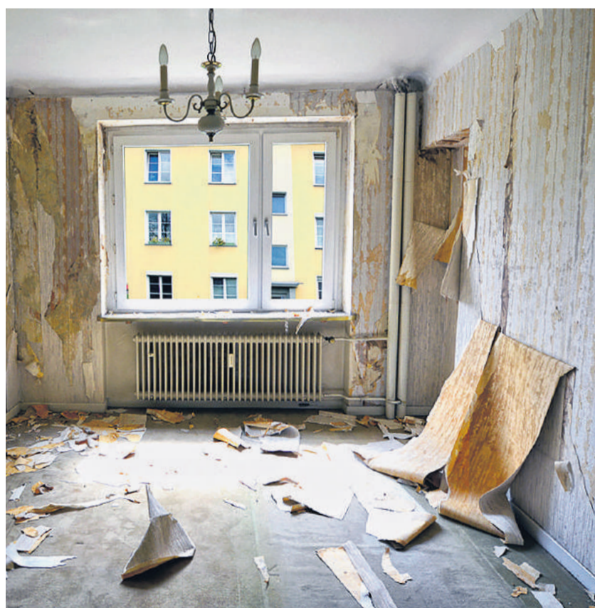
ABGENUTZT: Die Frage, wer nach Beendigung eines Mietverhältnisses für Schäden an der Mietsache aufkommen müsse, führt häufig zu Streit. FOTO: FOTOLIA
