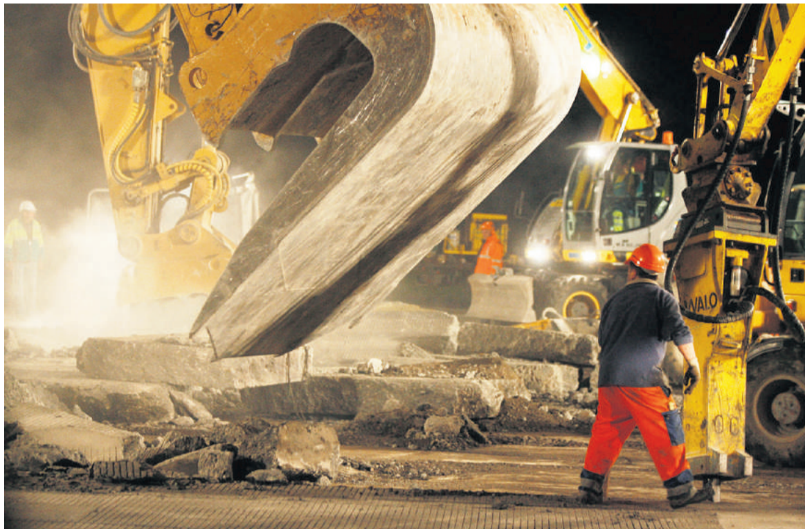
NUR IN AUSNAHMEFÄLLEN: Nachteinsätze auf Baustellen (Symbolbild). FOTO: KEYSTONE
