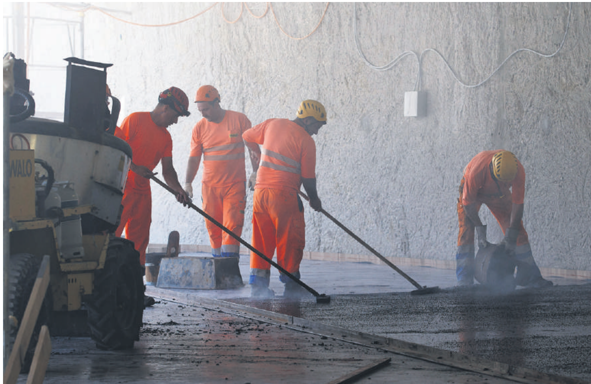
ANSTRENGENDER JOB: Büzern auf der Baustelle der Bahnlinie zwischen Genf und Annemasse (F). FOTO: KEYSTONE
