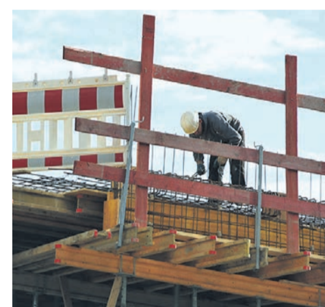
DURCHBRUCH: Die neuen Massnahmen machen die Kontrolle der Arbeitsbedingungen auf den Baustellen einfacher. FOTO: KEYSTONE
