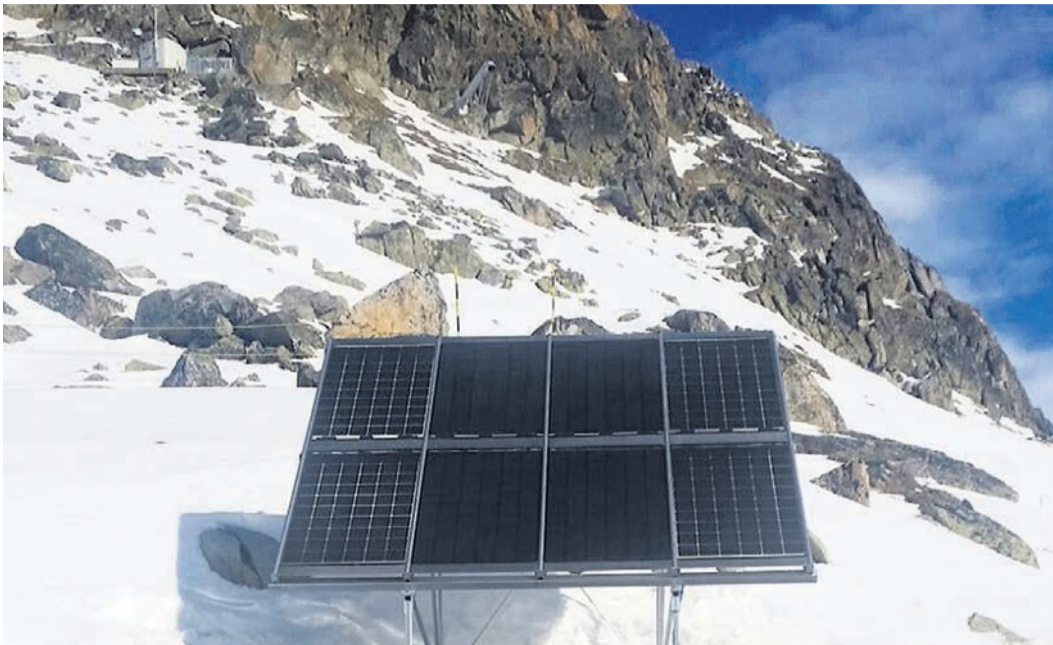
VON VORNE UND VON HINTEN: Die Solarmodule auf dem Walliser Bettmerhorn produzieren nicht nur mit der direkten Sonneneinstrahlung Elektrizität. Sondern auch mit den Reflexionen im Schnee. FOTO: EMPA
