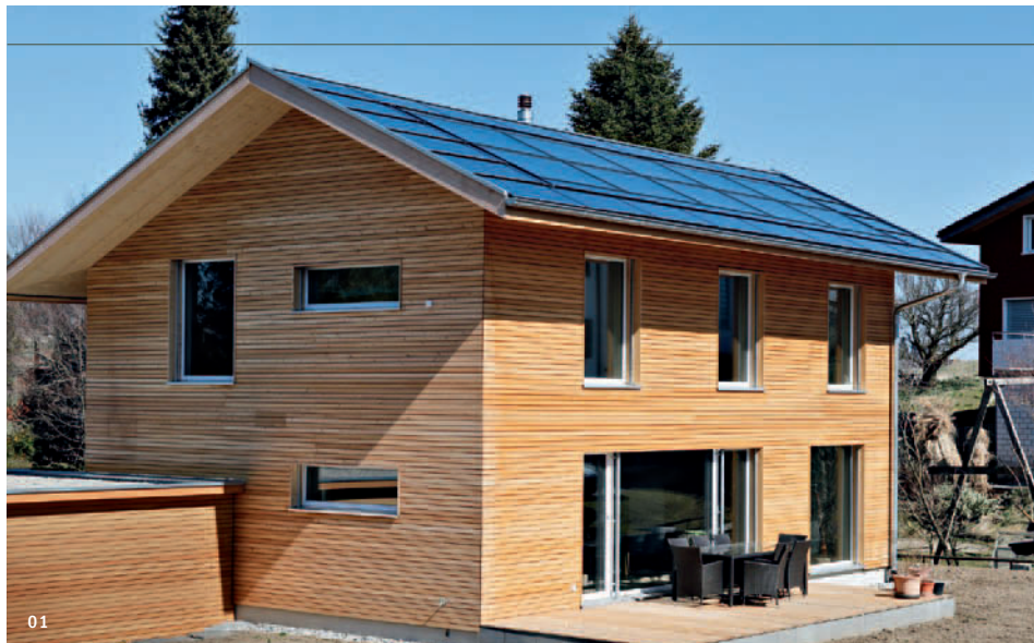
01 UND 02 EIN ZUKUNFTSFÄHIGES KONZEPT: DAS HAUS MIT DER KOMBI-INDACH-ANLAGE IN SCHWARZENBURG.
