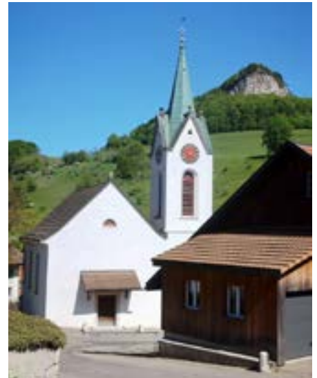
L'église de Wisen-Flueberg au pied du Flueberg.
