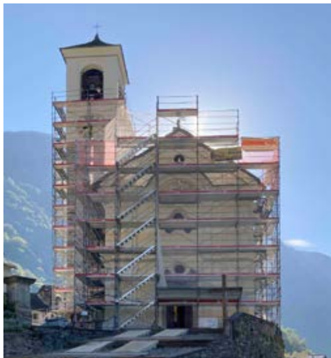
La chiesa di Maria Sant'Angelo, in Valle Verzasca, è stata impalcata. (Fotogr.: mad)
