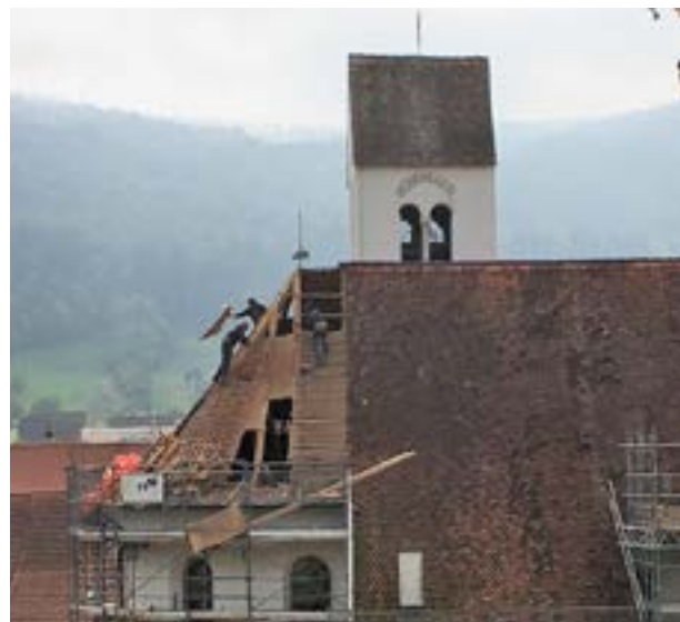
La ristrutturazione del tetto ad un'altezza elevata sopra il coro. (F.: mad)
