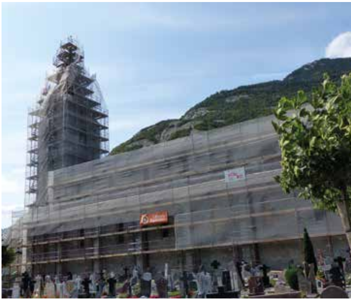
Die eingerüstete Pfarrkirche von Ardon.
