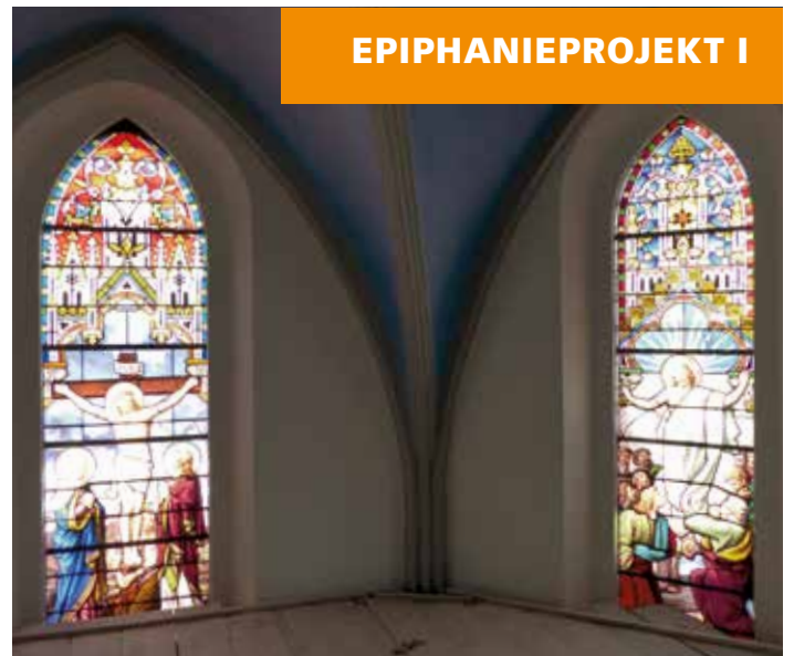
Restauration der eindrücklichen Glasfenster im Innern.
