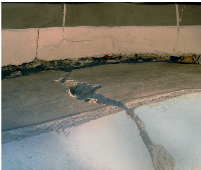
Fissures, humidité et attaques fongiques (à droite) menacent l'église.
