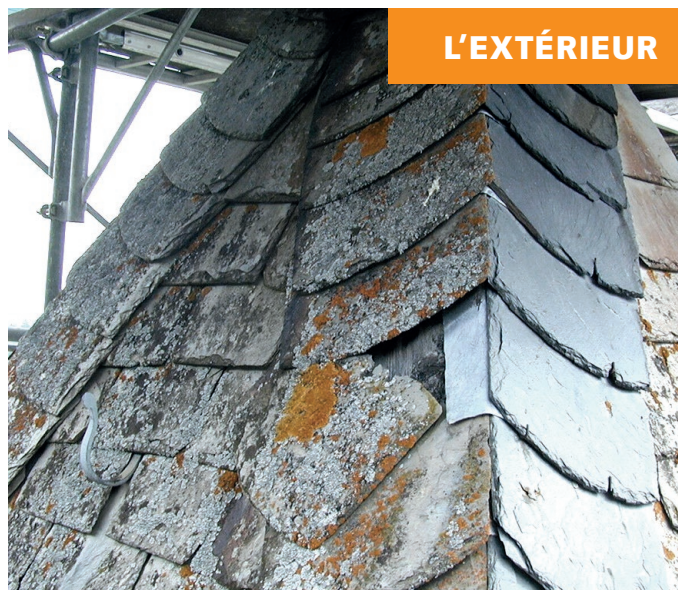
Rénovation urgente du clocher endommagé par l'humidité.
