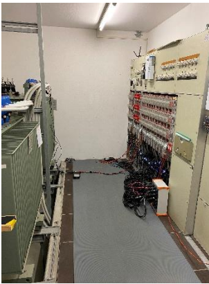
Messaufbau in der Trafostation
