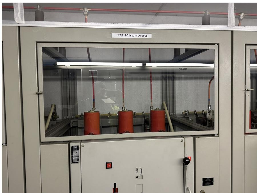
Alte luftisolierte 16kV Schaltanlage
