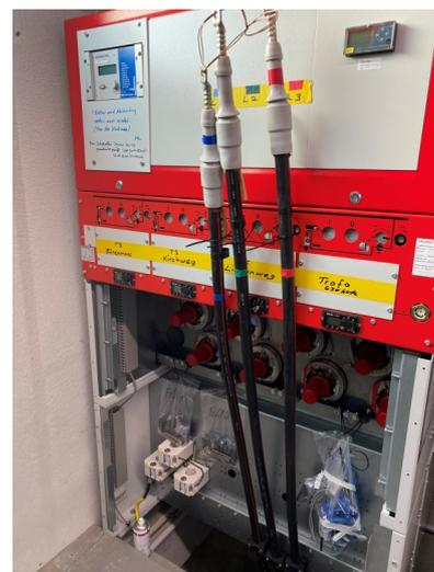
Neue ölisierte 16kV Schaltanlage
