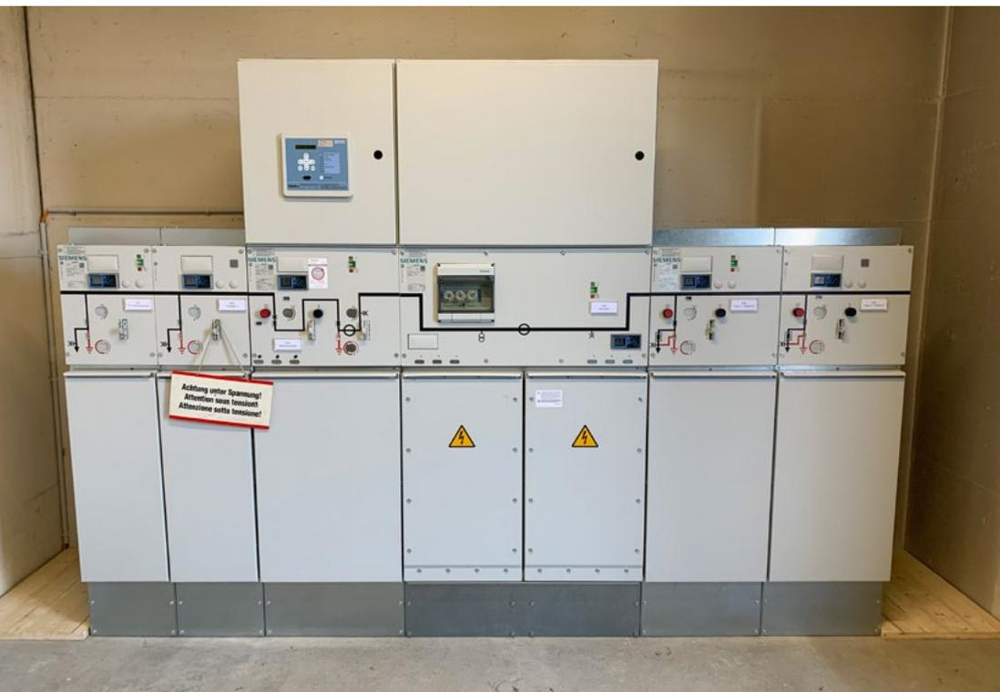
Neue 16000 Volt Kompakt-Schaltanlage mit Messfeld
