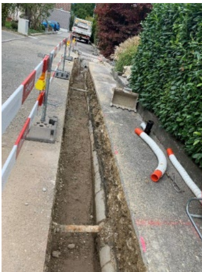
Bild 1: Graben für zusätzliche Kabelschutzrohre
