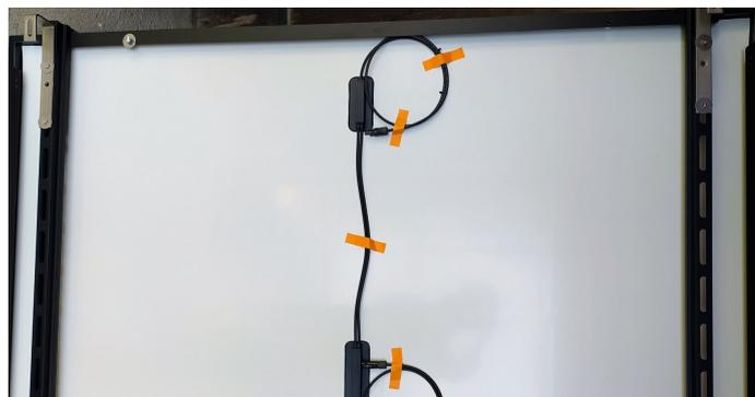
Wechselrichter an der Vorbereiteten Schraube festschrauben, sodass die Stecker nach rechts zeigen und der Wechselrichter vom Rahmen absteht.
