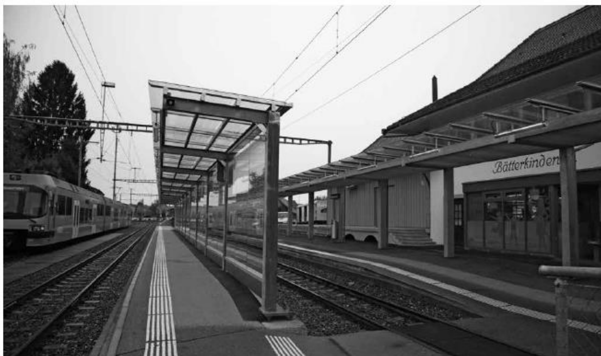
Die Bauarbeiten am Bahnhof Bätterkinden sind kurz vor dem Abschluss.
